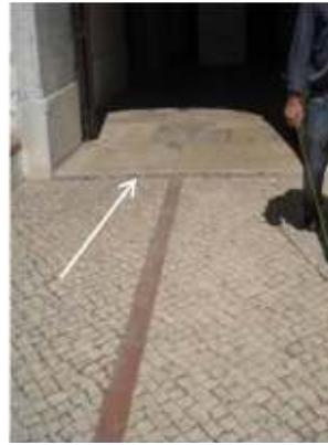
**Intervenção** – Nivelamento do pavimento eliminando o ressalvo existente
