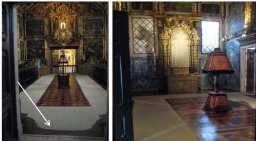
**Intervenção** – Construção de uma rampa em madeira, que não danifica o chão de madeira trabalhada. Substituição da alcatifa.
